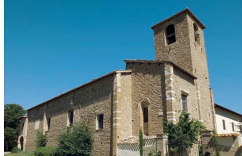
Chiesa di San Francesco, Pontelatrave Church of San Francesco, Pontelatrave
